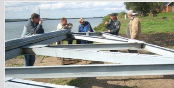
Изготовление гидросооружений плотины ФЕРМЫ ПОАРЭ Московская область, Луховицкий р-н, Белоомут, ГИДРОУЗЕЛ.
