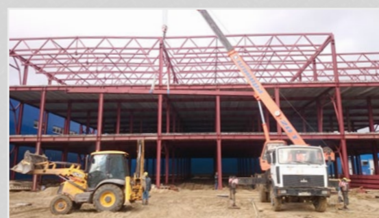
Трехэтажное здание промышленного назначения 54x66 м. г. Железнодорожный
