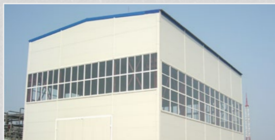
Здание компрессорной UNIT-1500 Месторождения западной части Бортового лицензионного участка Саратовской области.
