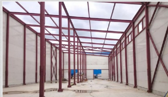
Складское здание 60x18 м. г. Железнодорожный, Московская область.
