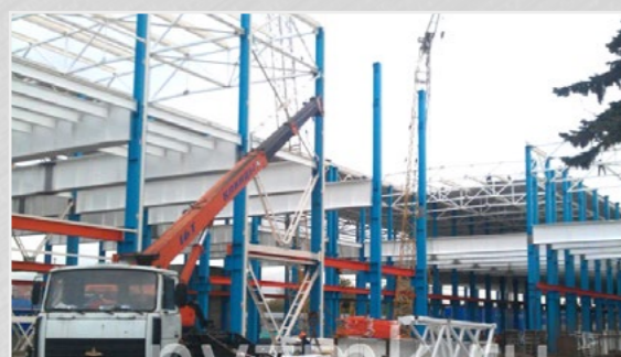
Монтаж металлоконструкций Люберецкого Завода Монтажавтоматика г. Люберцы.
