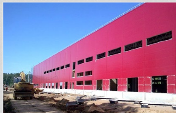
Торгово-Выставочный Центр п. Вешки, Московская область.
