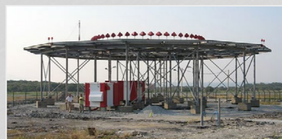
Радиомаяк азимутальный доплеровский DVOR DME 2000. Изготовлены и смонтированы на 46 аэродромах
