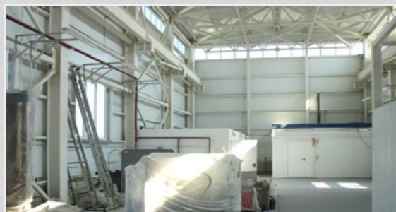
Ремонтно-механическая мастерская. г. Майкоп
