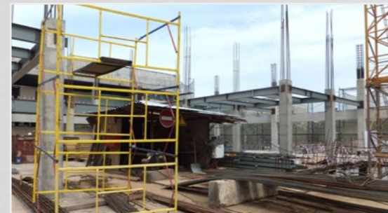
Трехэтажный физкультурно-оздоровительный комплекс с бассейном. Московская область, г. Мытищи.
