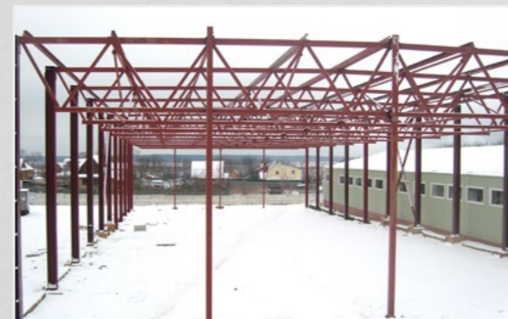
Производственное здание 60x24 м. г. Железнодорожный.
