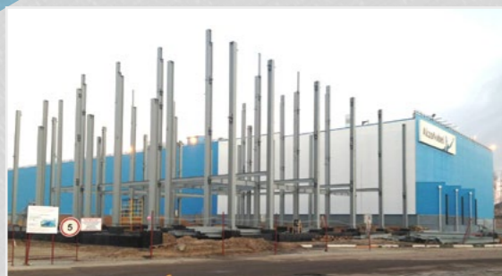
Изготовление металлоконструкций для компании AkzoNobel USA. г. Орехово-Зуево.
