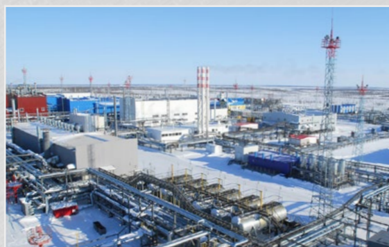
Здания ДКС КОС и Насосной масел г. Новый Уренгой.
