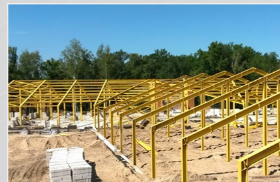
Промышленное здание. Воронежская область
