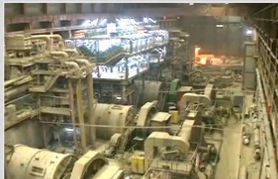
Корпус мелкого дробления АО «Апатит» Мурманская область, г. Кировск
